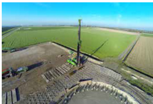
Voor Windpark Zuidwester, onderdeel van windpark Noordoostpolder, leverde en installeerde Voorbij Funderingstechniek zestig prefabpalen per windturbine.
